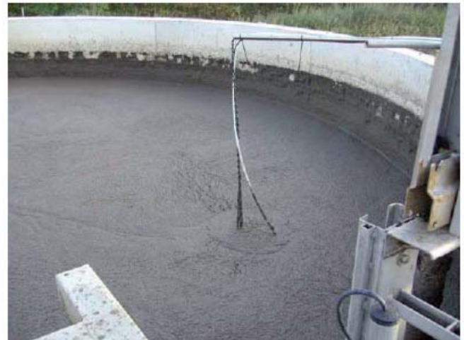
図 1. ハーナウ(ドイツ)の排水処理プラントの SB リアクターでの VARiON センサーの使用状況
