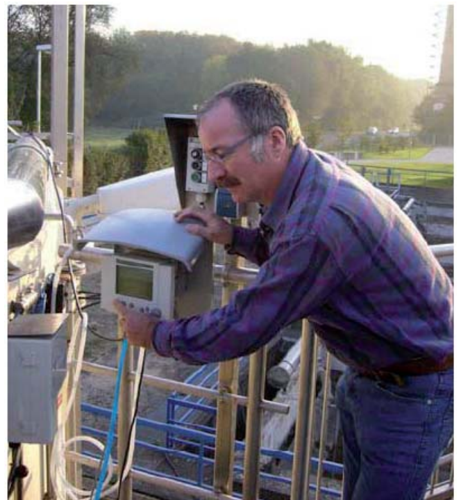
図 2. IQ SENSOR NET システムと VARiON センサーを使用中のハーナウ排水処理プラントの Faust 氏
