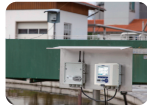
界面レベルセンサー IFL700IQ による界面レベル測定
