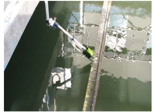
- 汚泥掻き寄せ機対策のデフレクターキット
