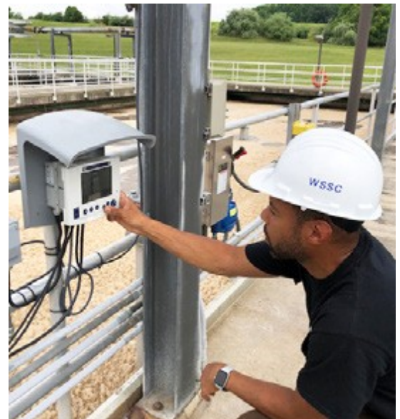
Seneca WRRFのGreg WhitleyがIQ Sensor Netシステムを使用してチェック
