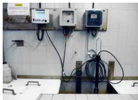
スペクトルセンサーの設置(右)とコントローラーMIQ/TC 2020 XTの設置
